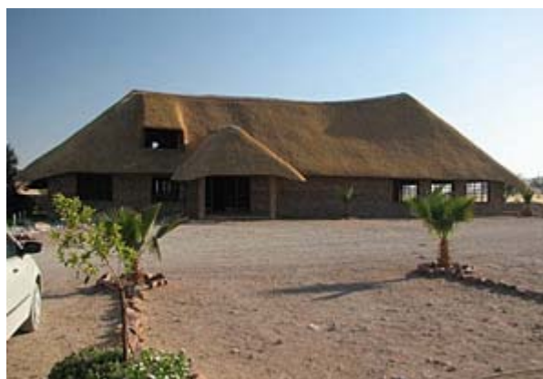
neues Restaurant im Bau
